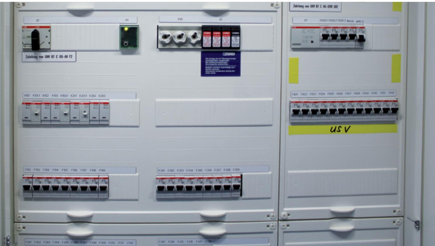
Etagenverteilung mit notstromversorgten Stromkreisen, Quelle: BBK
