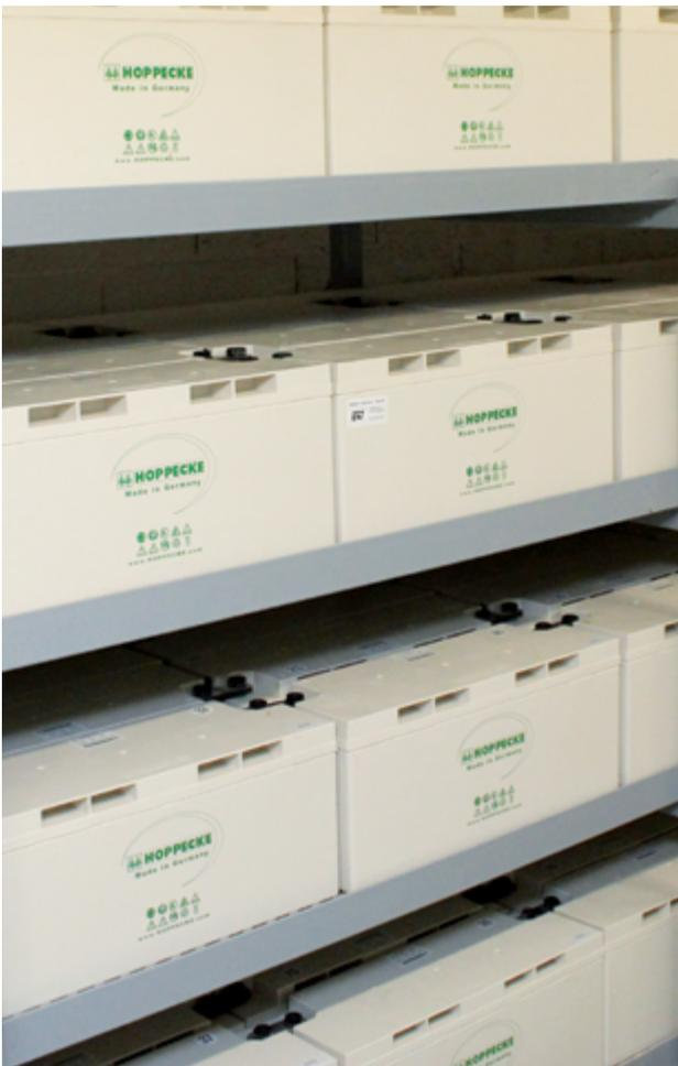
Batterieanlage für eine unterbrechungsfreie Stromversorgungsanlage
