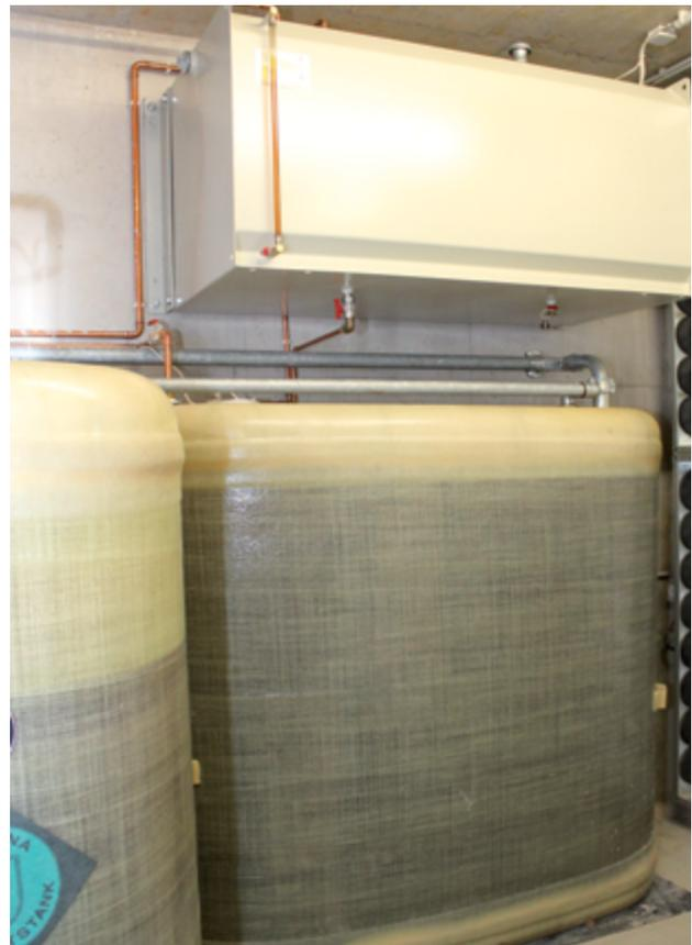
Haupt- und Tagestank einer Netzersatzanlage Quelle: BBK
