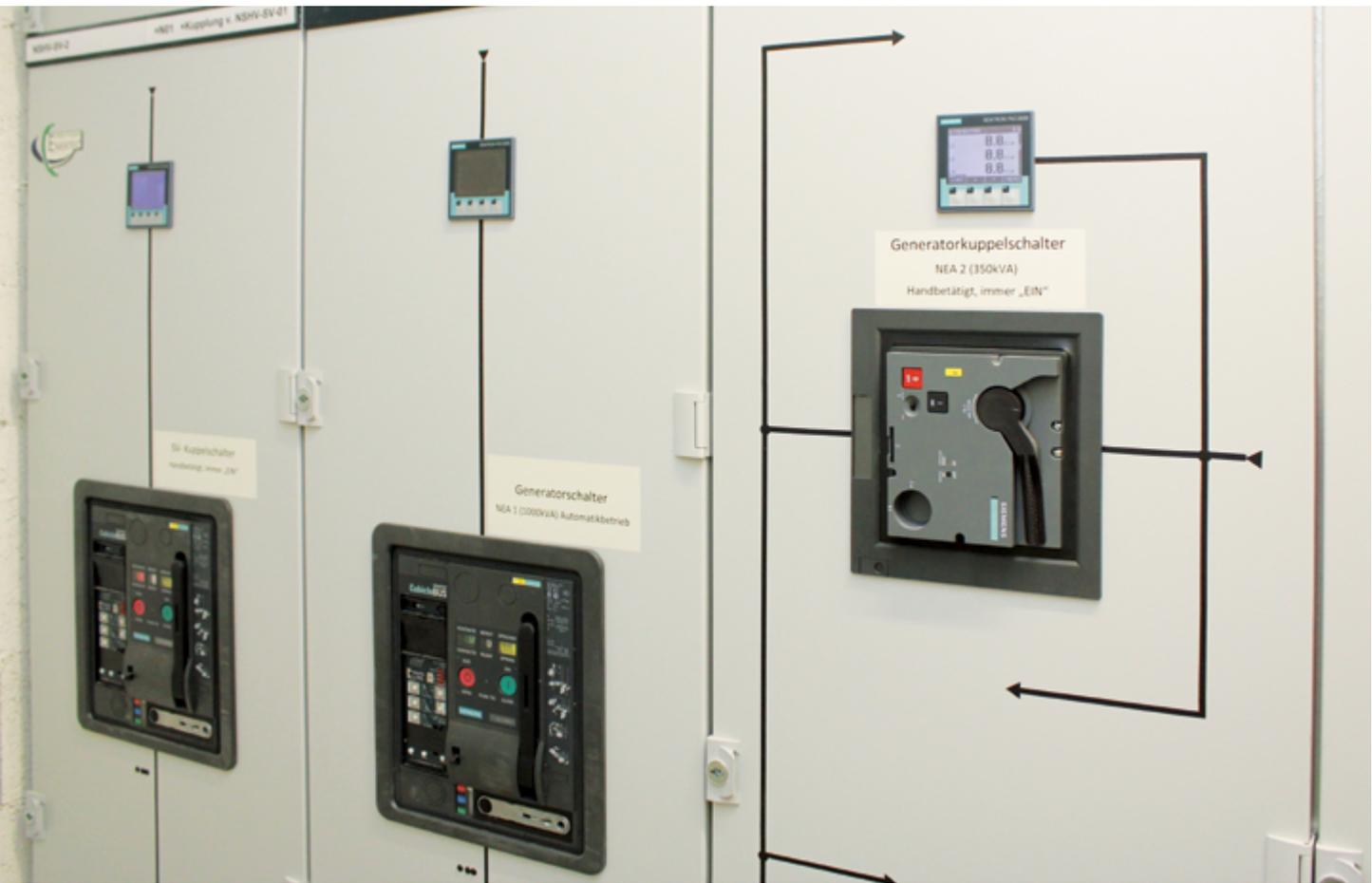
Schaltanlage einer modular aufgebauten Netzersatzanlage, Quelle: BBK
